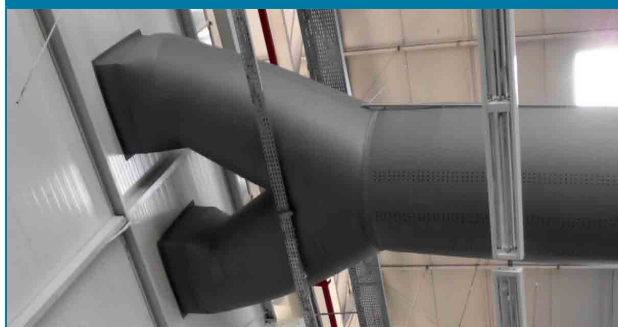
Conectarea tubulaturii la gura de introducere
