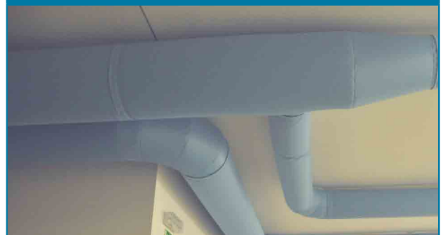
Tubulatura de transport
